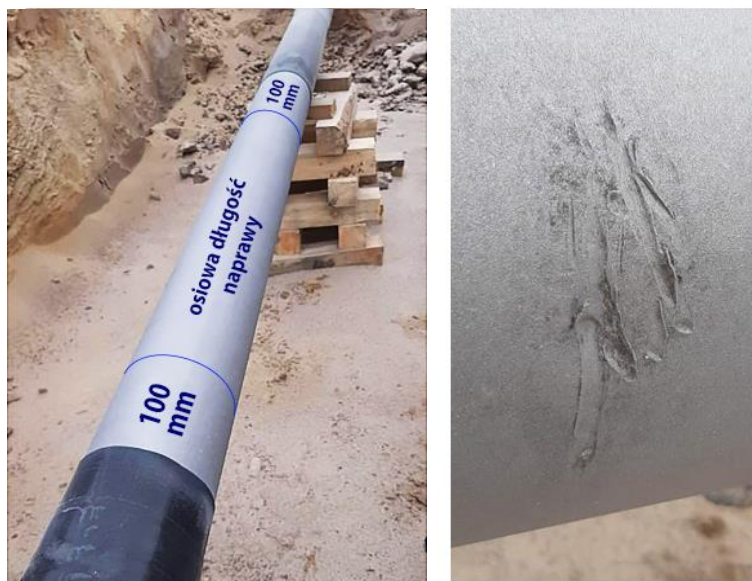
Rys.2. Przygotowanie powierzchni do stopnia czystości Sa 2½
