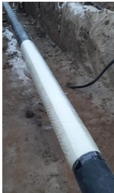
Rys. 6. Zaaplikowany materiał kompozytowy Inover Wrap MCU z folią kompresyjną.
