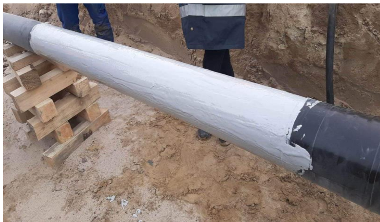
Rys. 4. Aplikacja podkładu Inover Primer MCU
