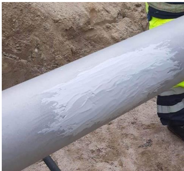
Rys. 3. Aplikacja materiału wypełniającego Inover Filler MCU
