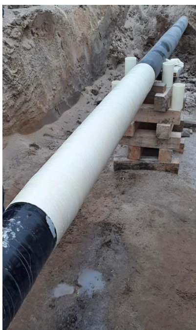
Rys. 5. Zaaplikowany materiał kompozytowy Inover Wrap MCU
