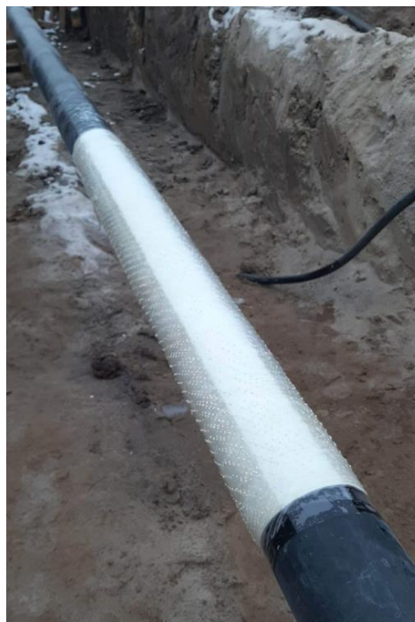
Rys.5 Zaaplikowany materiał kompozytowy Aquawrap® z folią kompresującą
