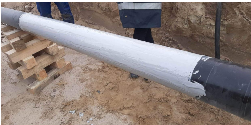
Rys.4 Aplikacja podkładu Bio-Dur 563
