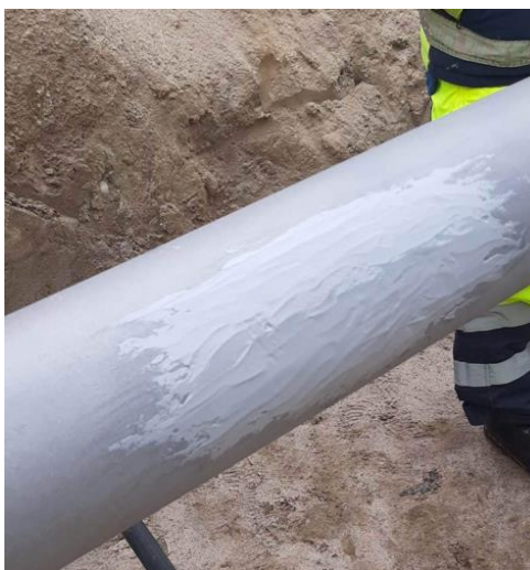
Rys.3 Aplikacja materiału wypełniającego Bio- Fix 913 TM
