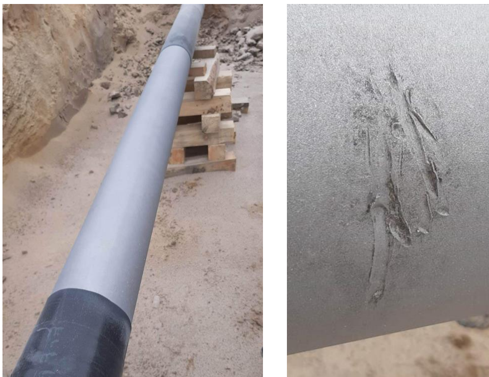
Rys.2 Przygotowanie powierzchni do stopnia czystości Sa 2 ½
