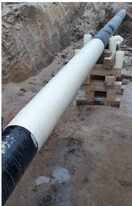
Rys.5 Zaaplikowany materiał kompozytowy Aquawrap®
